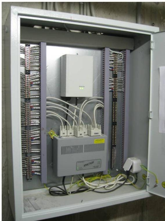
Подключение точек обслуживания и линии связи с пультом диспетчера осуществляется кабелями из комплекта блока через клеммные колодки ЩРД.
